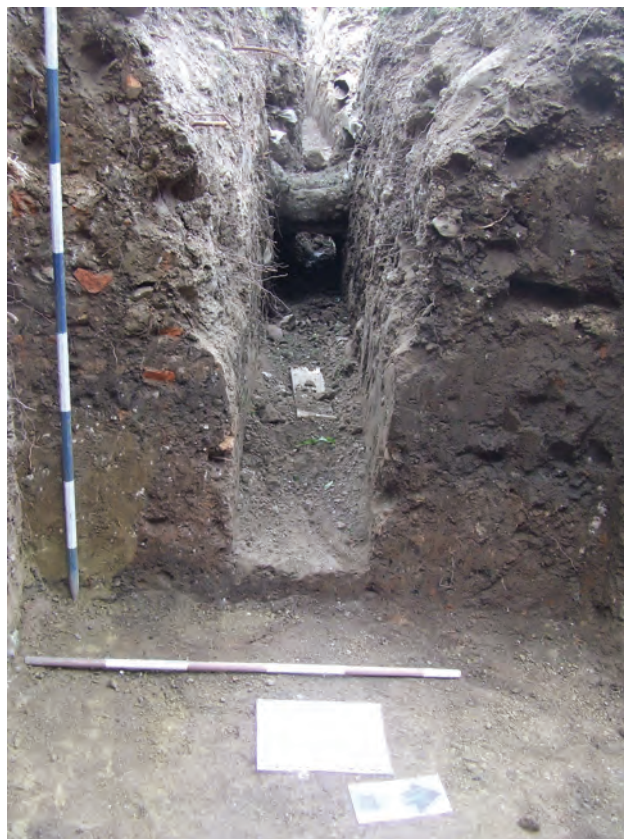
Figura 37. Foto profil vestic al gropii G1 până la adâncimea la care s-a executat șanțul de introducere a rețelei de apă / Photo of the western profile of pit G1 at the depth of the water supply system.
