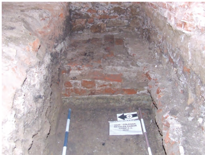
Figura 17. Secțiunea S1, foto soclu sobă / Area S1, photo: base of a stove.
