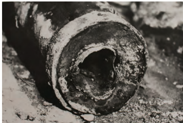
Figura 30. Detaliu conductă lemn (fotografie de arhivă) / Wooden pipe detail (archive photo).
